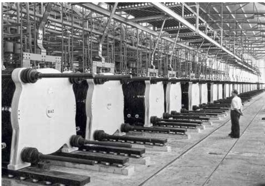
Elektrolyse er udover at Poul la Cour for 125 år siden også anvendt i Norge, hvor man har haft øje for forsyningsikkerheds-aspektet og muligheden for at lave biobrændsler ved hjælp af brint. Her ses et norsk 135 MW-anlæg i 1953.
