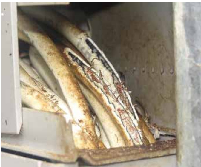
Til venstre: Ledninger til måleren. Isoleringen er gravet helt væk ind til kobberet. Foroven: Isoleringen er gravet af højspændingskablerne.
