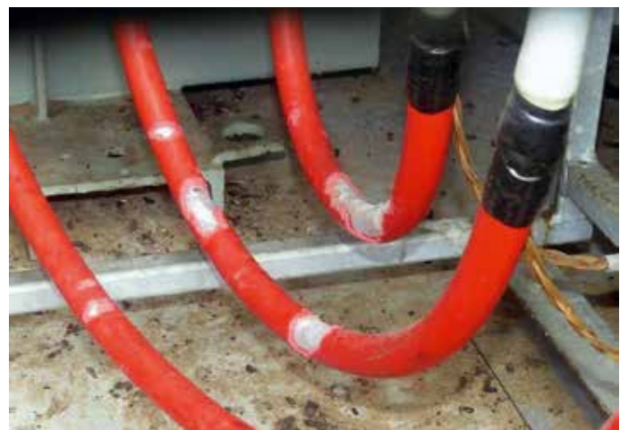
Til venstre: Ledninger til måleren. Isoleringen er gravet helt væk ind til kobberet. Foroven: Isoleringen er gravet af højspændingskablerne.
