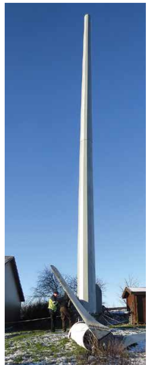
Havari af Kingspan 6 kW
