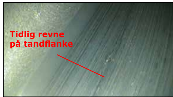
Garantiudløb. Tandskade konstateret i MW gear ved garantiudløb.
