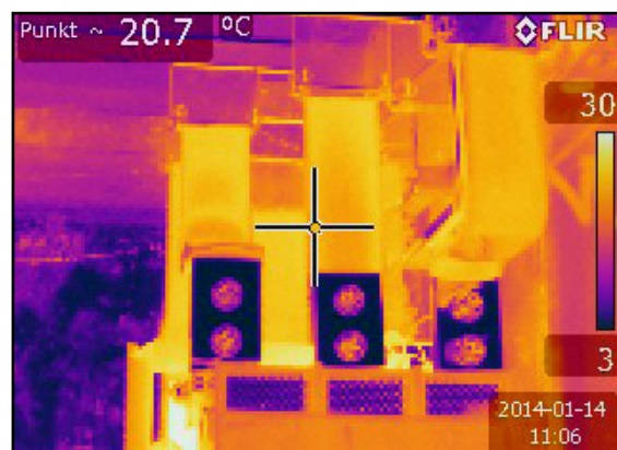
Termografi af kobberskinner og forbindelser til kontakter i tavle.
